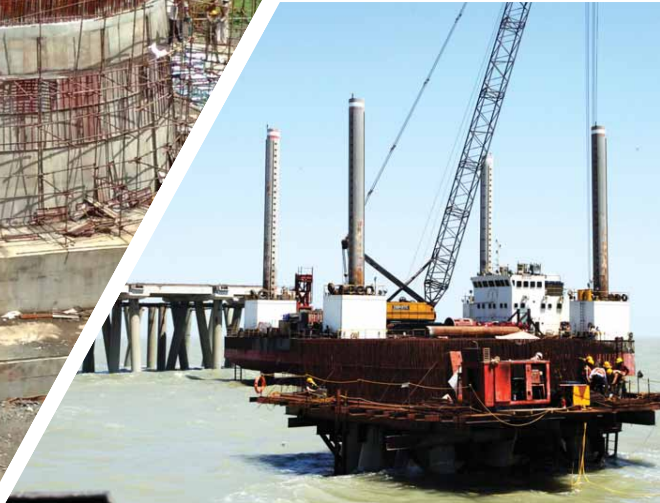
LNG Jetty under construction at Mundra Port for GSPC LNG Ltd. at Gujarat
